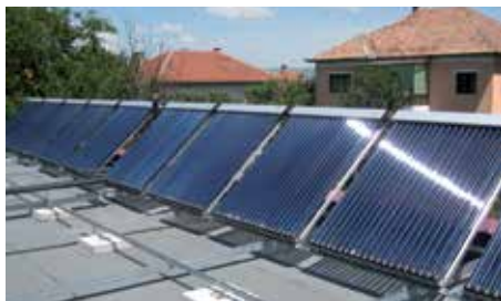
Система с применением вакуумированных трубчатых коллекторов.
